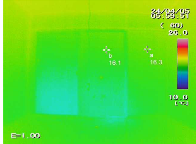
③断熱内窓住戸
