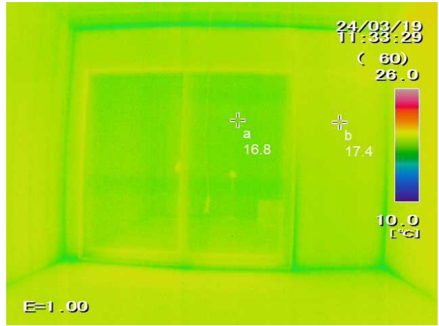
②断熱内窓・断熱壁改修住戸
