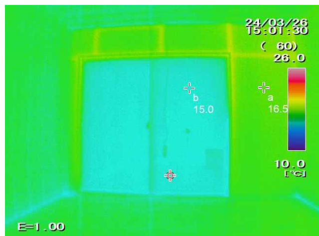
②断熱内窓・断熱壁改修住戸
