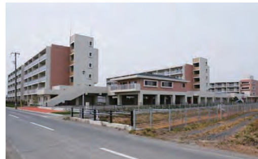
県営西木倉団地(亘理町 3棟 100戸)
