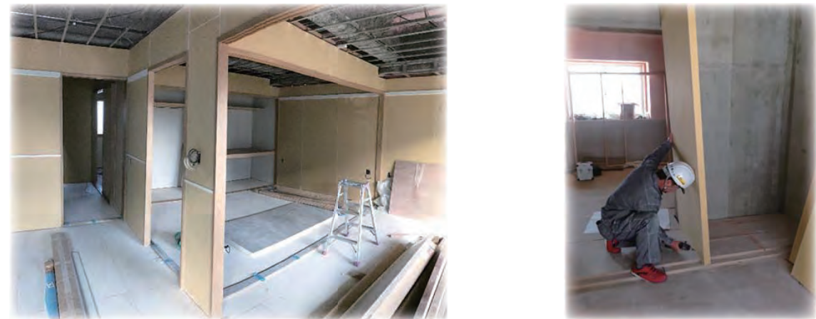
施工中の住戸内の様子（床先行、パネル工法）
