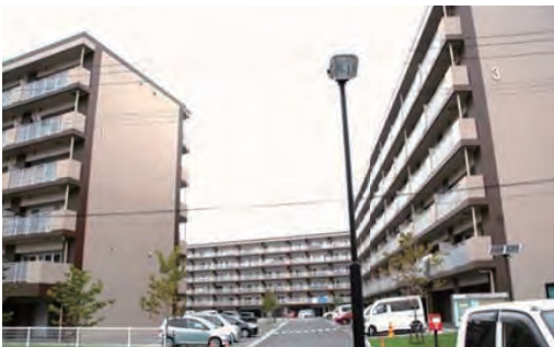
県営みどり町団地（大船渡市 3 棟 147 戸）
