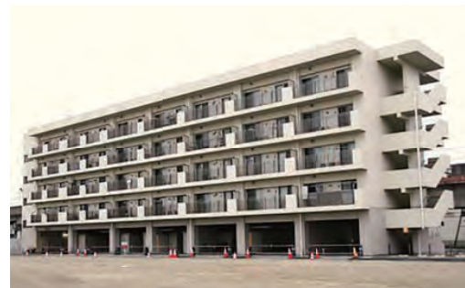
県営北浜団地第1期(塩竈市 31戸)
