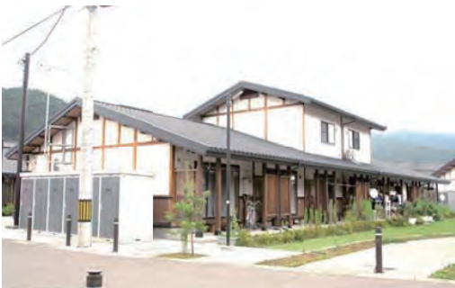
町営大ヶ口住宅（大槌町 5 戸）
