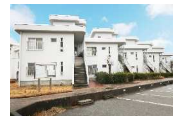
令和元年東日本台風水害公営住宅団地の復旧工事
