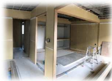
施工中の住戸内の様子
