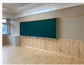
台形集成材採用事例(大阪府内産材) 吹田市立千里丘中学校増築工事
