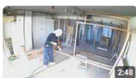
【パネ協 施工動画】内装化 : 粧パネル工法
