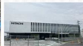
新製造棟外観
