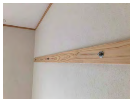
クリアー塗装を施した多摩産製付長押も採用されています。
