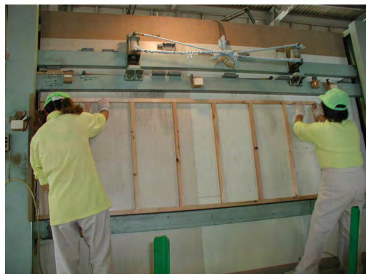
パネル工場でのコア組み工程
