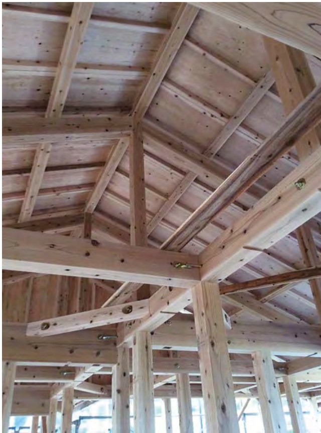
福岡県産杉 屋根パネル施工状況
