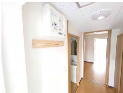
建設現場での内装プレハブ工事
