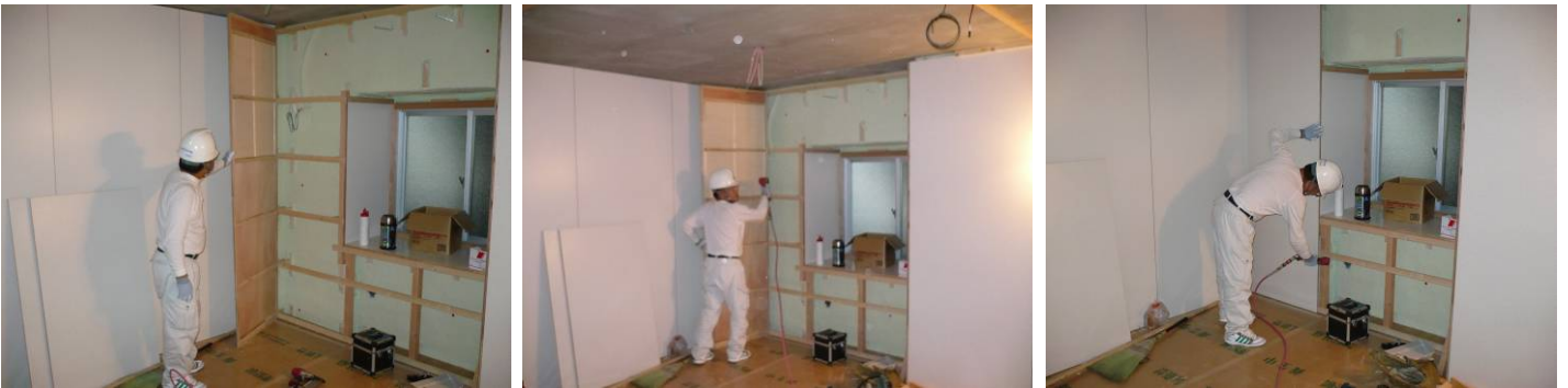
「あいち認証材」スギ芯材パネルの施工状況
